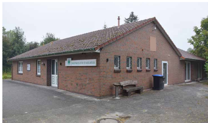
Deutlich mehr Licht gelangt durch den Einbau von zwei großen Fenstern (rechts im Bild) und einer Glastür in den Multifunktionsraum, dem ehemaligen Schießstand. . BERICHT UND FOTOS: HEINO SCHMIDT
